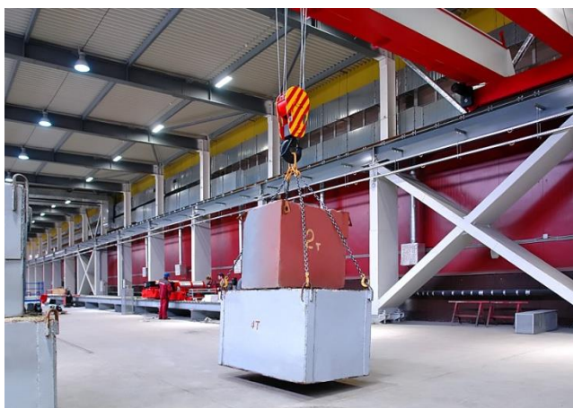
Рисунок 23 - Испытание мостового крана [15]
